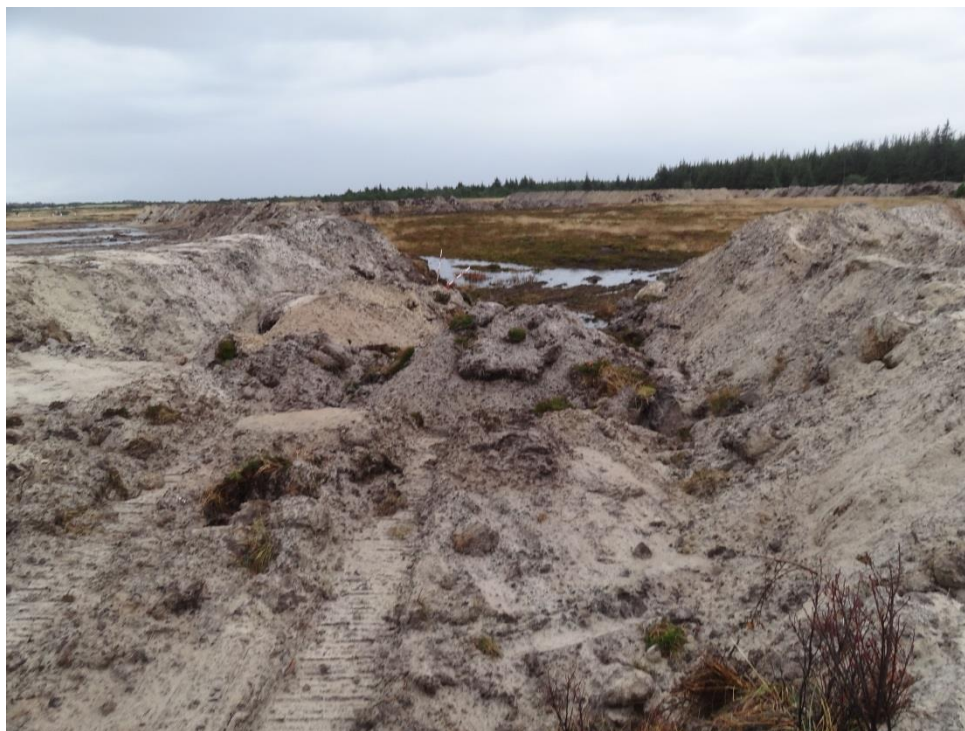
Figur 5: Voldene består af afskrabet jord, som er en blanding af den relativt næringsholdige topjord, og den mere næringsfattige underliggende sandjord. Det fremgår, at voldene nogle steder indeholder meget organisk materiale (centralt i foto), mens de andre steder fremstår som sandjord med meget lidt indblandet organisk materiale. Foto: 4. november 2013.
